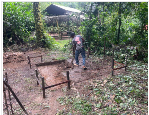
Vorbereitung des Fundaments (© Pandrillus)
