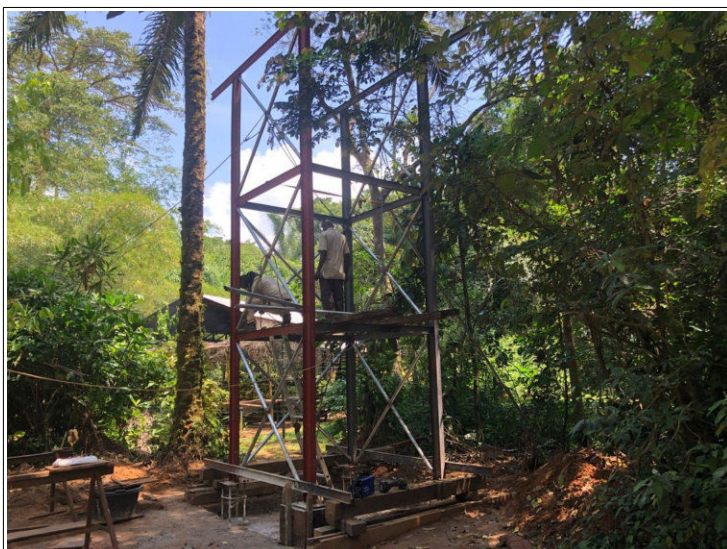
Fast fertig: Der Wasserturm (© Pandrillus)
