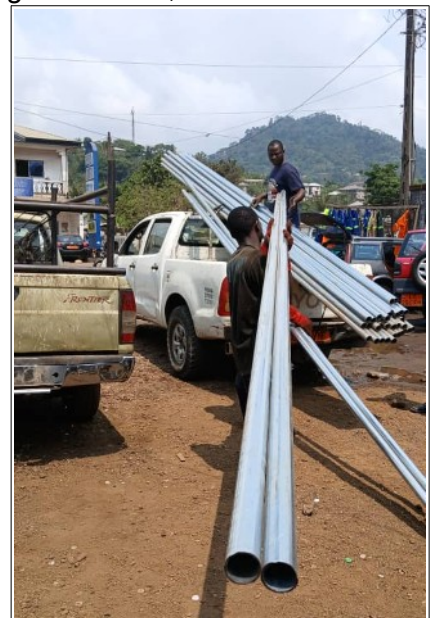
Transport des Materials für den Bau (© LWC)
