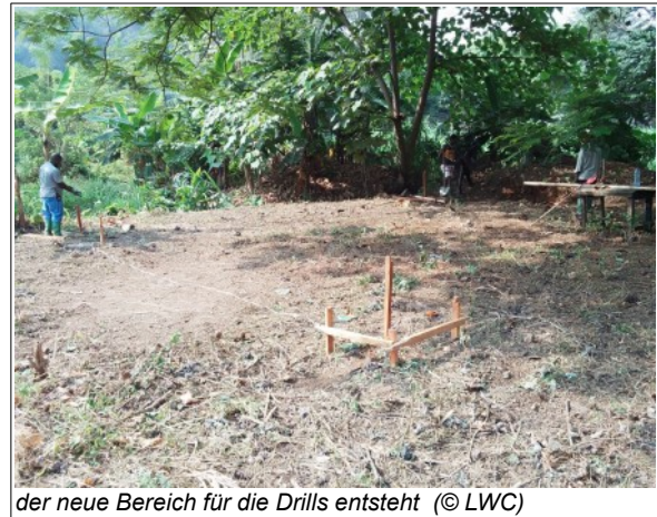
der neue Bereich für die Drills entsteht (© LWC)
