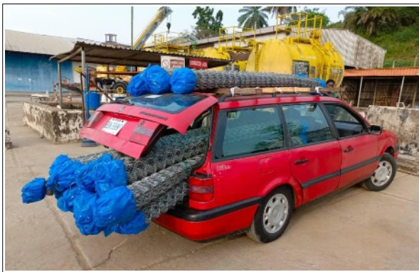
Transport des Materials für den Bau (© LWC)
