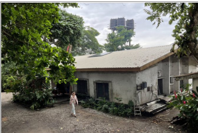
Auf dem fertig gestellten Dach wurde eine kleine Solaranlage installiert (Foto: Pandrillus)
