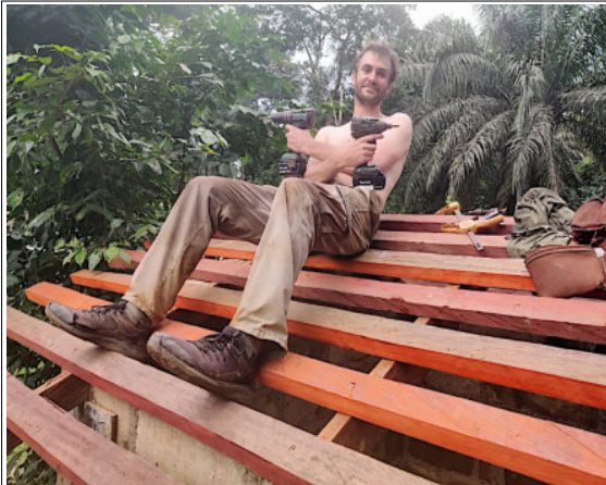
Zack Schwenneker – ein Multitalent für alle Fälle (hier in den Afi Mountains beim Dachbau)! (Foto: Pandrillus)
