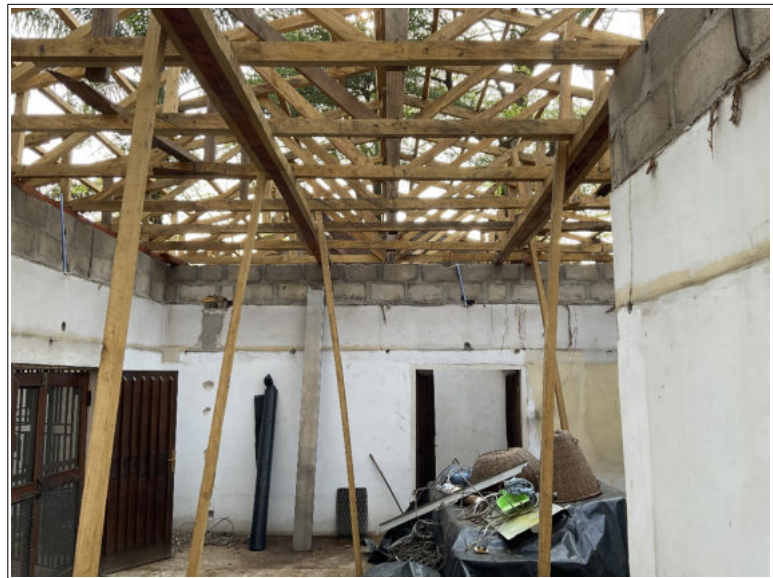
Die Wände sind aufgemauert, der neue Dachstuhl kurz vor der Fertigstellung. Doch noch sieht es wild aus... (Foto: Pandrillus)
