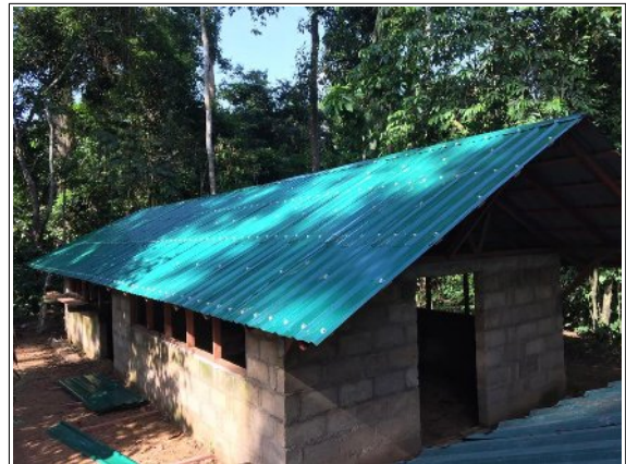
Grundmauern und Dach sind fertig
